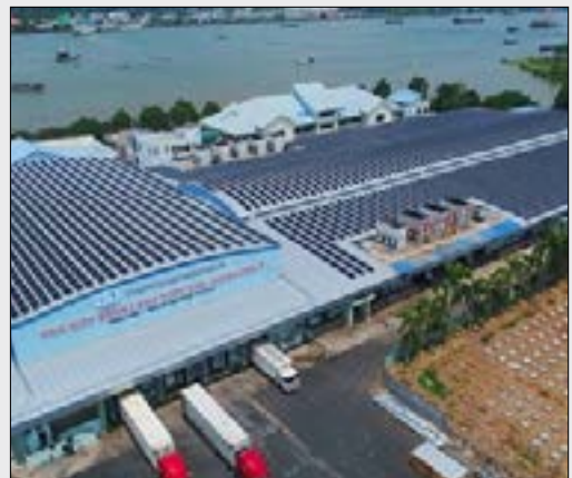
▲ Những tấm pin năng lượng mặt trời đã được lắp đặt tại Nhà máy Chế biến thủy sản đông lạnh số 1
