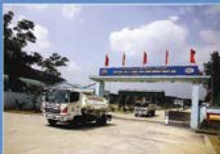
Nhà máy xử lý chất thải công nghiệp nguy hại
